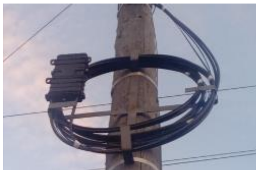
Рис. 1. Установленная на телефонный столб, Кросс-муфта
